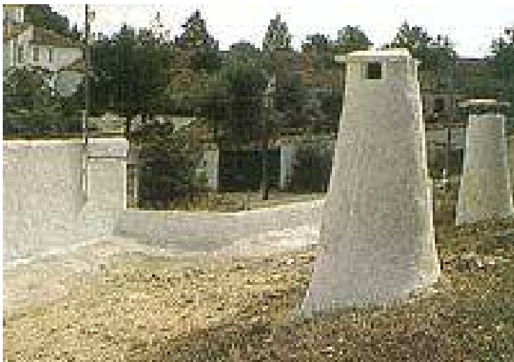
Chimeneas de casas-cueva (Fuentidueña de Tajo)
