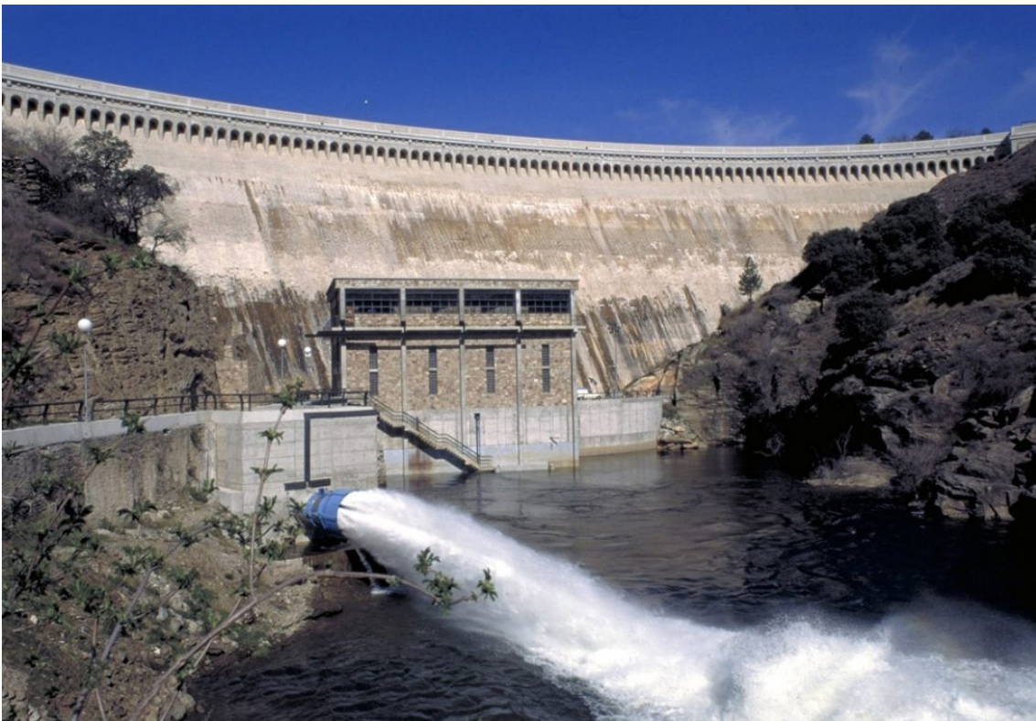
Presa de Puentes Viejas
