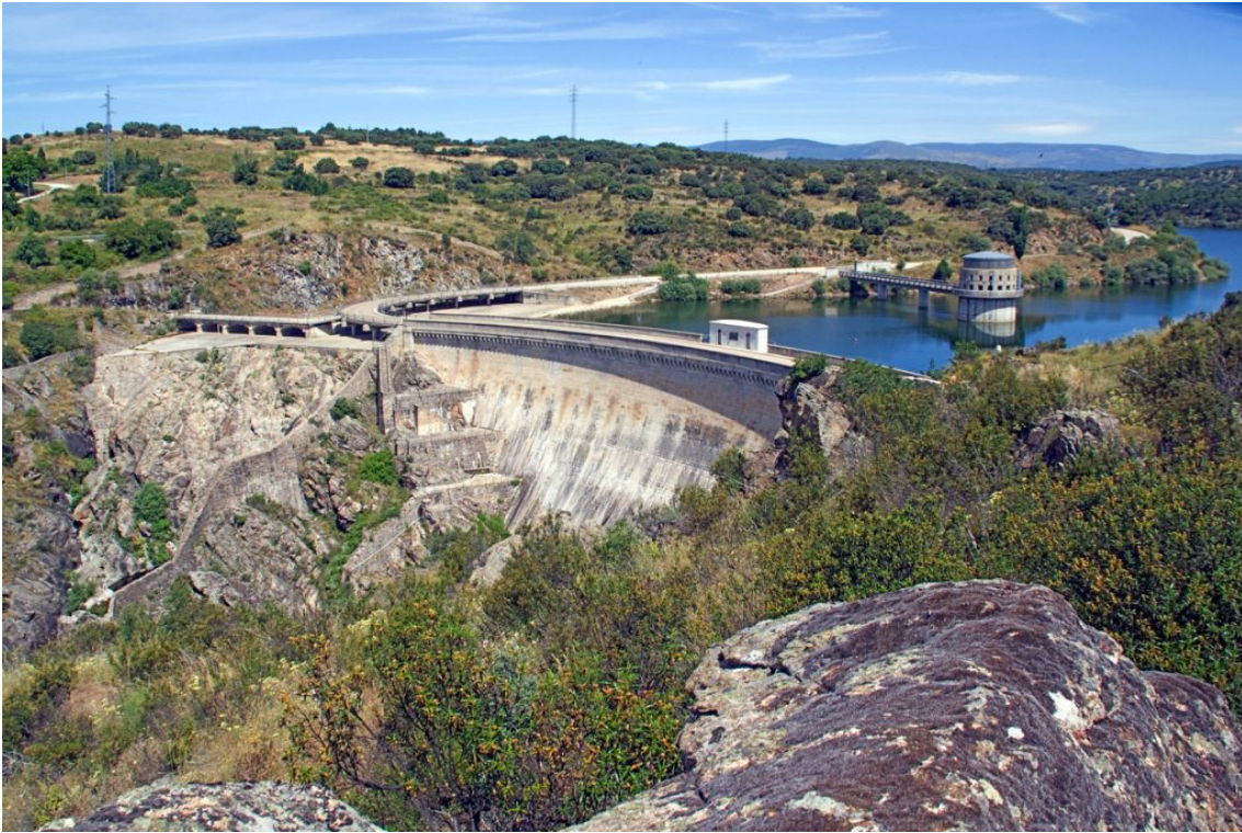
Embalse de El Villar: dique, aliviadero y torre
