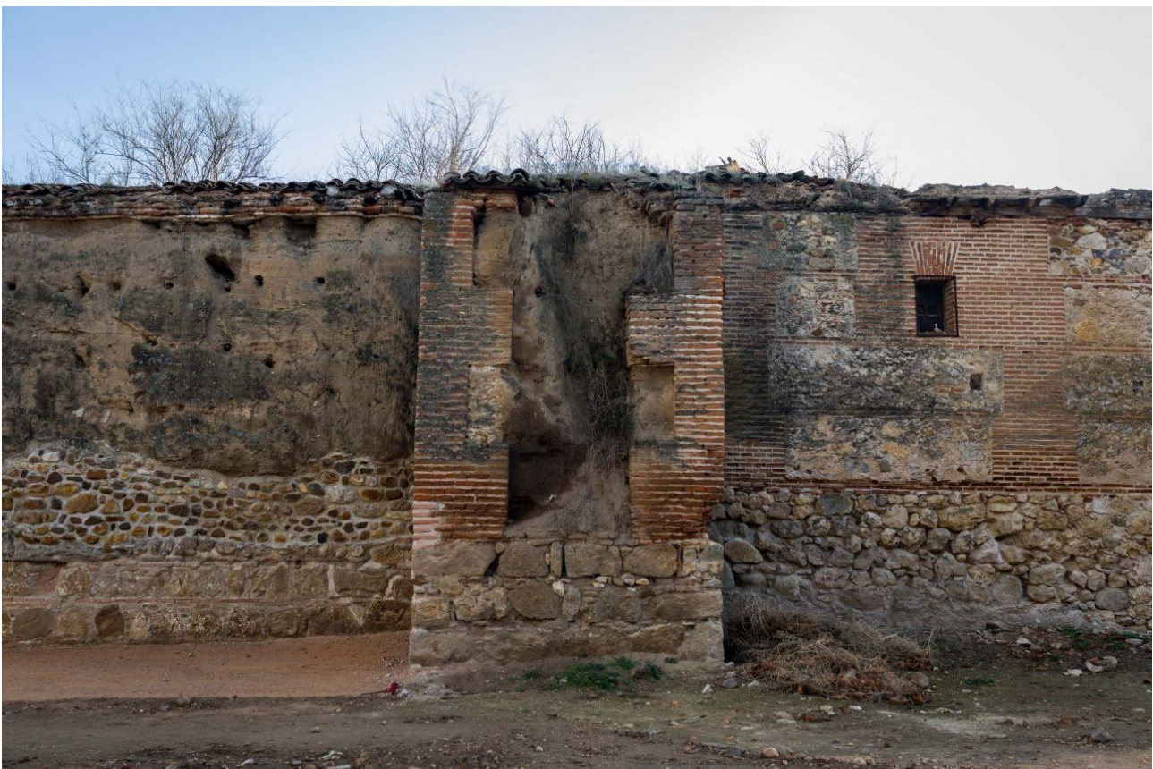
Muralla de Talamanca: torreón reconstruido
